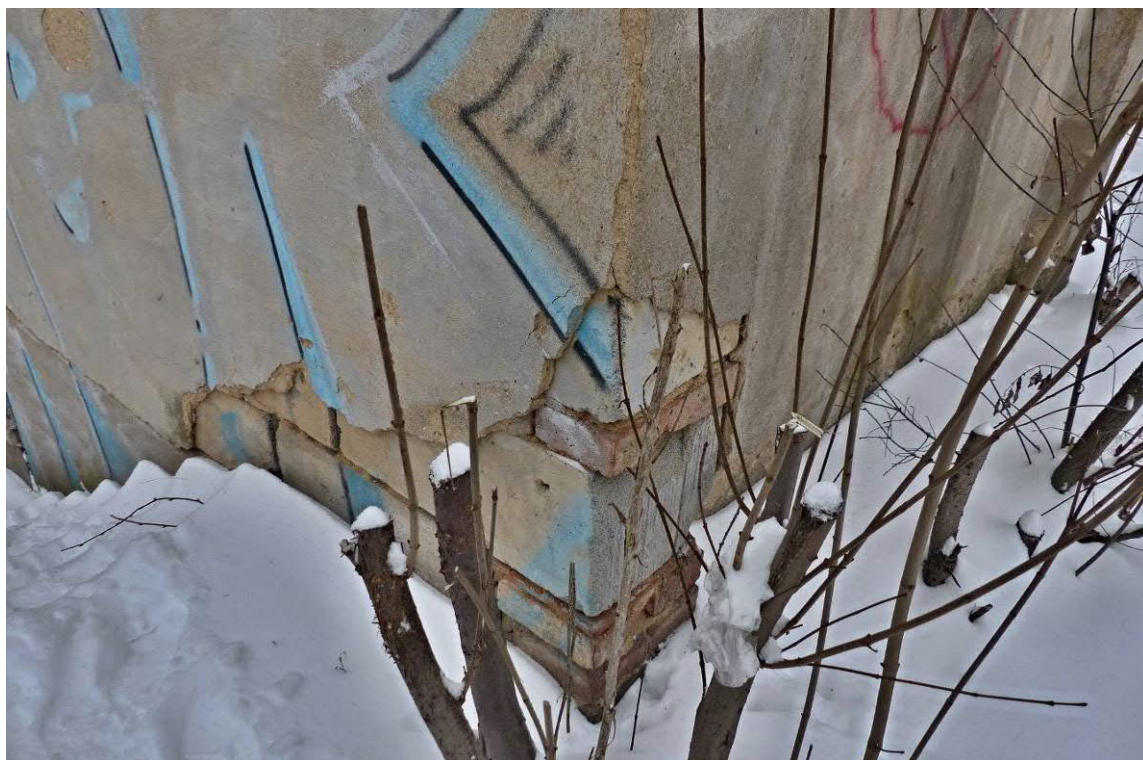
Foto č. 23 dolní část přístavku je plošně bez omítky Východní štítová fasáda
