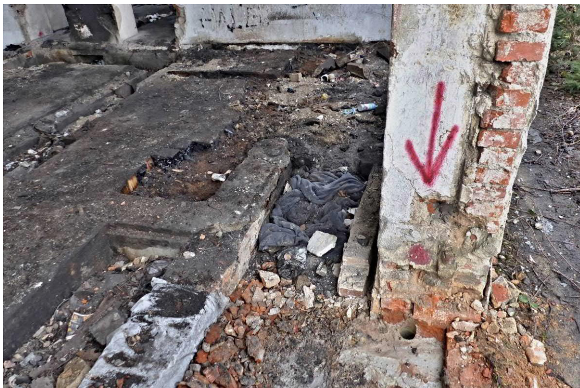
Foto č. 40 Pohled na místo vrtu S1 - dl. 1,90 m - pod základy obvodová zeď ostění pravého okna u severní fasády
