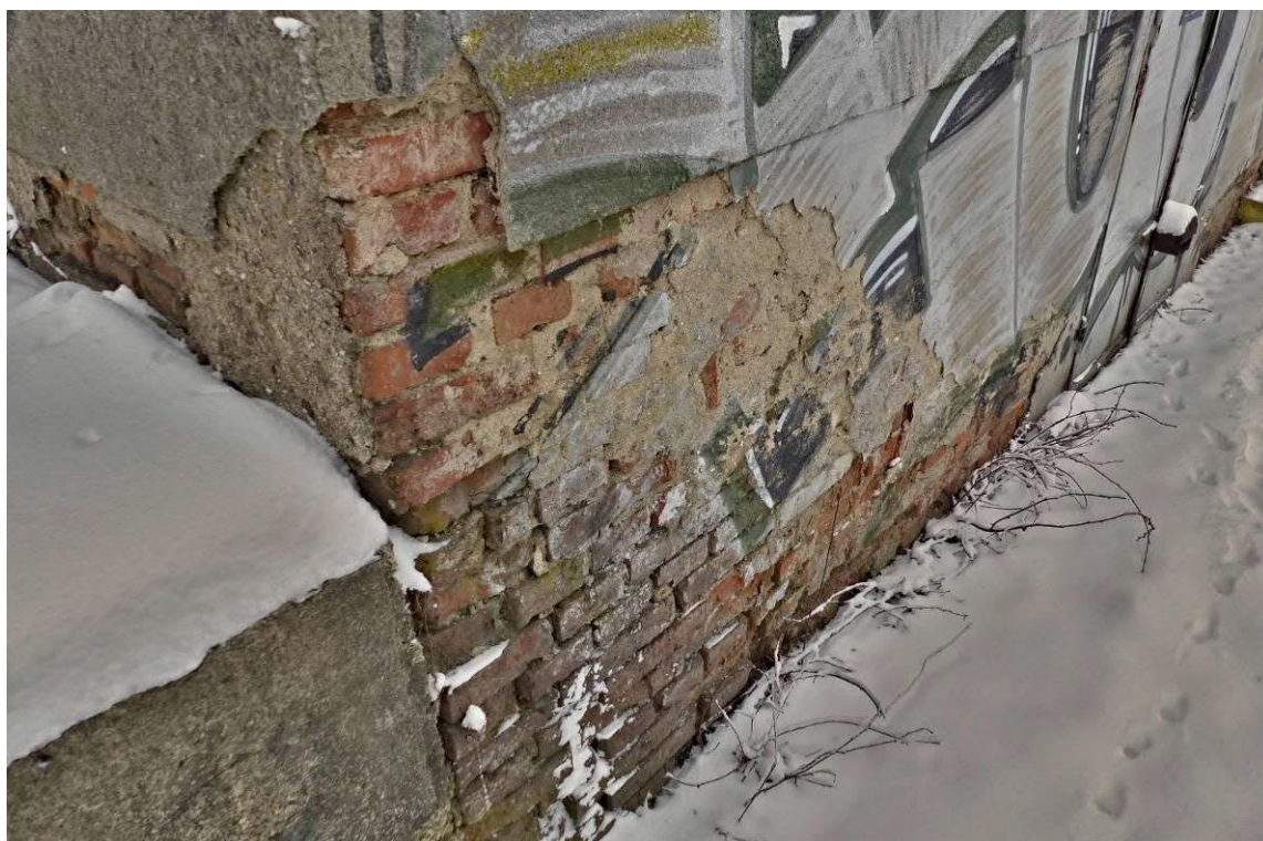
Foto č. 31 levý spodní okraj fasády má opadanou omítku Jižní fasáda trafostanice
