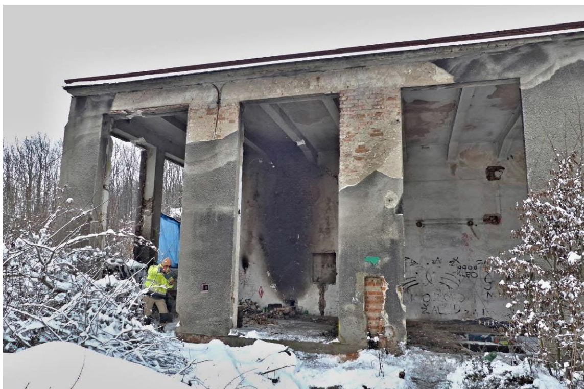
Foto č. 17 na 2. a 3. cihelném pilíři zleva je plošně opadaná omítka Severní fasáda svařovny směrem od nádraží
