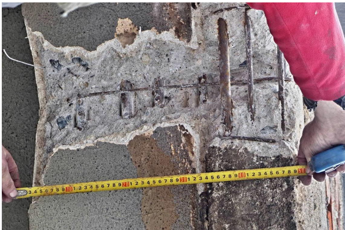
Foto č. 112 Ověření spodní podélné výztuže bylo uskutečněno na obvodovém průvlaku ŽB1 Průvlak nad východním oknem sonda ŽB1
