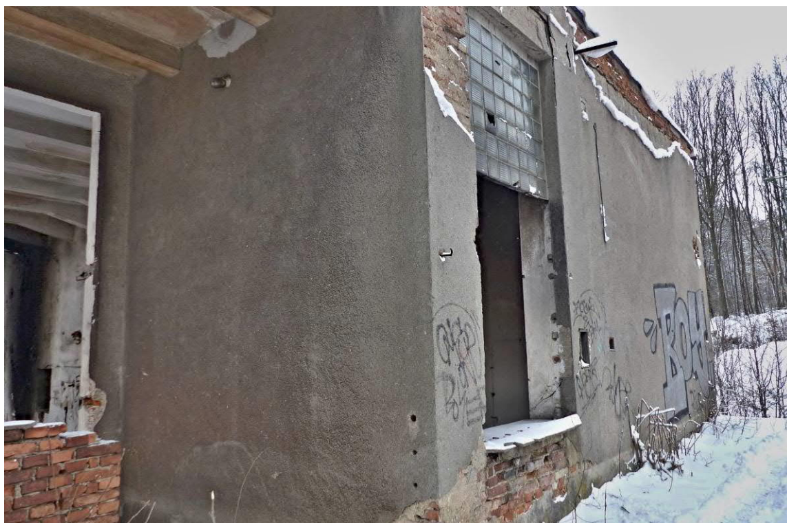
Foto č. 37 dolní část je místy bez omítky Západní štítová fasáda
