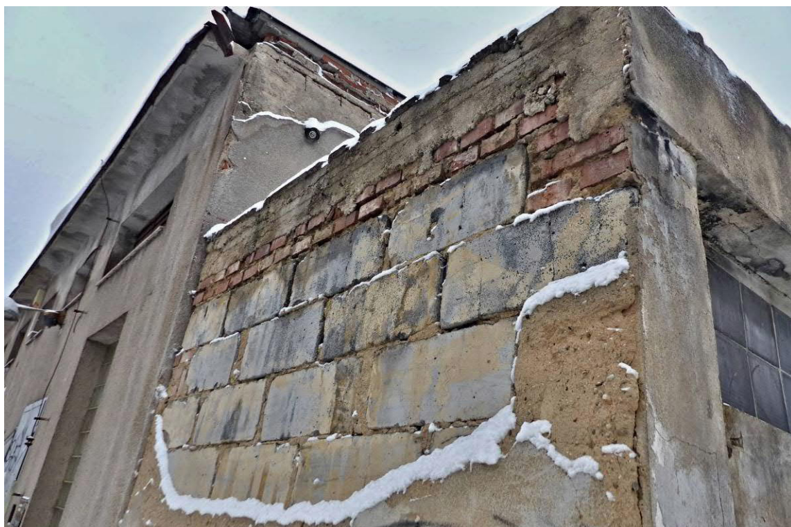
Foto č. 24 horní část přístavku je plošně bez omítky Východní štítová fasáda
