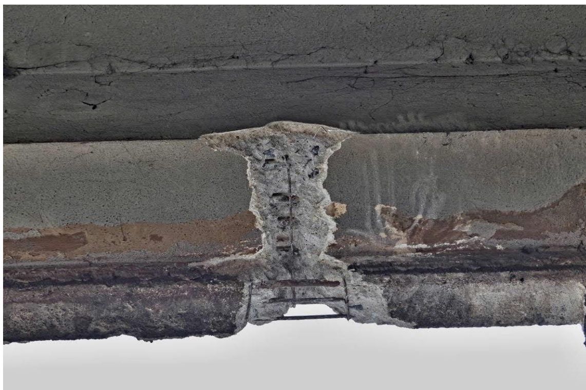
Foto č. 111 Celkový pohled na místa sond na podhledu stropu
