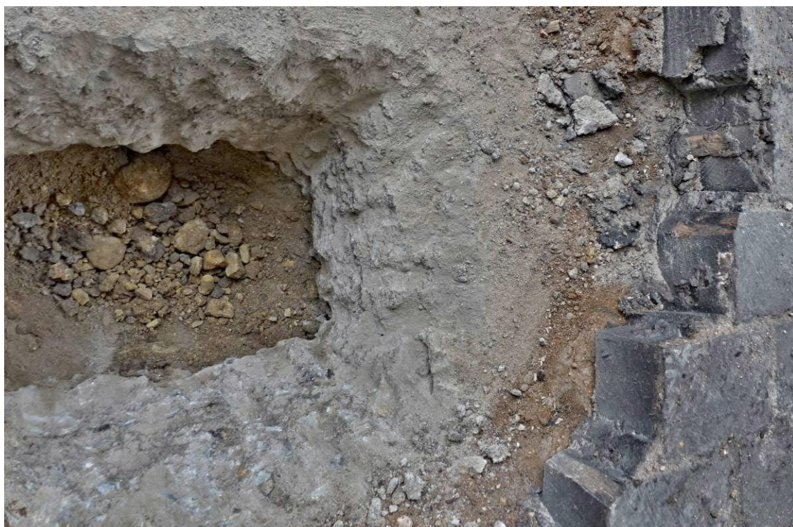
Foto č. 93 Pohled na sondu do podlahy kopaná sonda P1 dřevěné špalíky – svařovna
