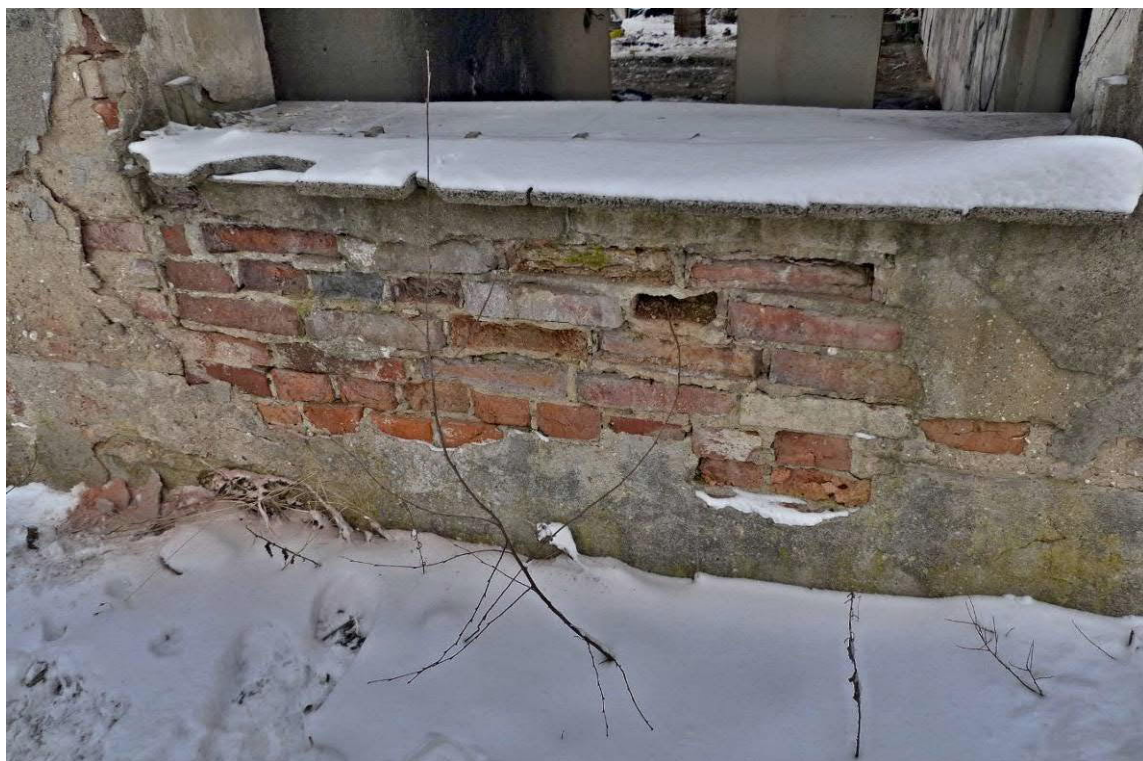
Foto č. 38 omítka pod oknem je plošně opadaná a cihly jsou zde silně vydrolené a poškozené Západní štítová fasáda
