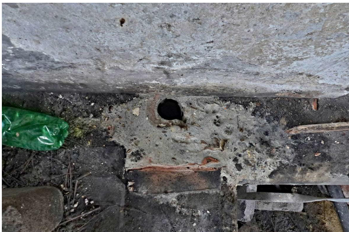
Foto č. 50 Pohled na místo vrtu S2 - dl. 1,84 m pod základy střední nosné zdi
