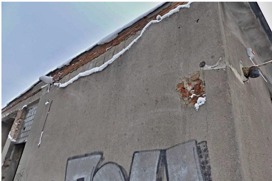
Foto č. 39 opadaná omítka v pravé horní části fasády Západní štítová fasáda
