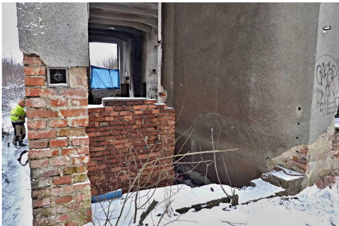
Foto č. 36 dolní část je místy bez omítky Západní štítová fasáda
